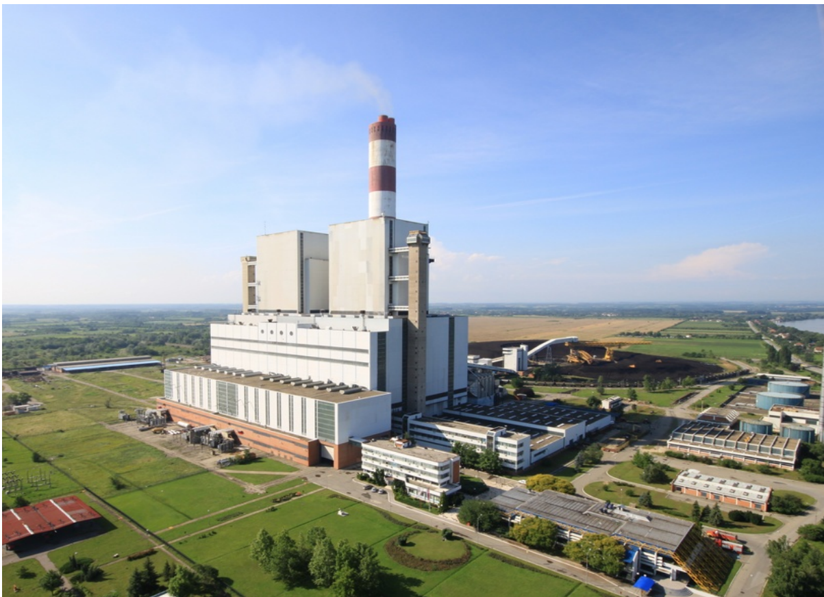
Slika 5.1. a) Deponija (pepelište sa prskalicama) ; b) Termoelektrana „Nikola Tesla B“, Obrenovac
