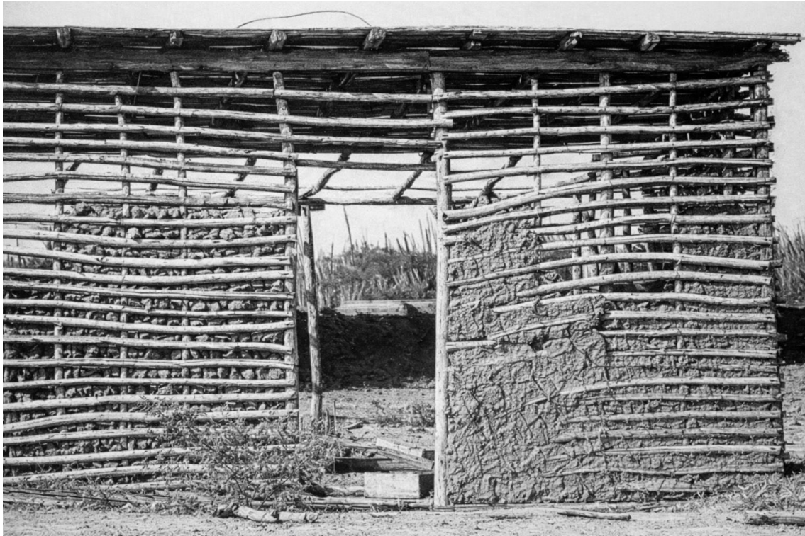
Слика 6.4. Пример традиционалне градње плетера и лепа у Венецуели (Преузето из: Minke, G. 2006. Building with Earth: Design and Technology of a Sustainable Architecture. , 81, fig.9.3.)
