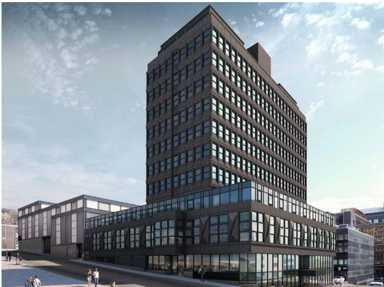
Слика 26. Хотел Sandman , Глазгов, Шкотска, Велика Британија – Northland Properties (извор: Scotishconstructionnow )
