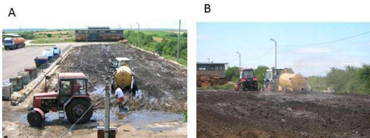
Slika 2.6 Proces ex-situ bioremedijacije.
