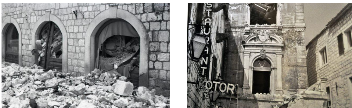
Слика 24. и 25. Рушевине у старом граду, Котор (извор: objektiv.me)
