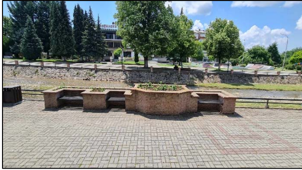
Слика 151 – бетонске клупе на кеју
