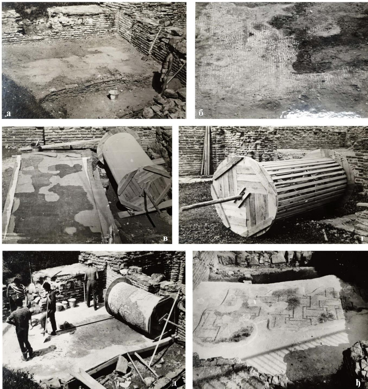
Слика 33. Конзервација мозаика у просторији 34 (М34): а) Мозаик прекривен тер папиром; б) Заштитни цементни малтер по ободу мозаика је испуцао; в) Припрема фрагмента 2 мозаика М34 за подизање помоћу дрвеног ваљка; г) дрвени ваљак за подизање мозаика до 6 m 2 површине; д) Фрагмент 2 мозаика М34 намотан на ваљак и припремљен за полагање на нову подлогу; ђ) Мозаик постављен на нову подлогу, (Извор: Документација ПЗЗСКНС, Досије бр. 1/Г Сирмијум – Сремска Митровица – Мозаици 1а – 14, 16, 23, 34).
