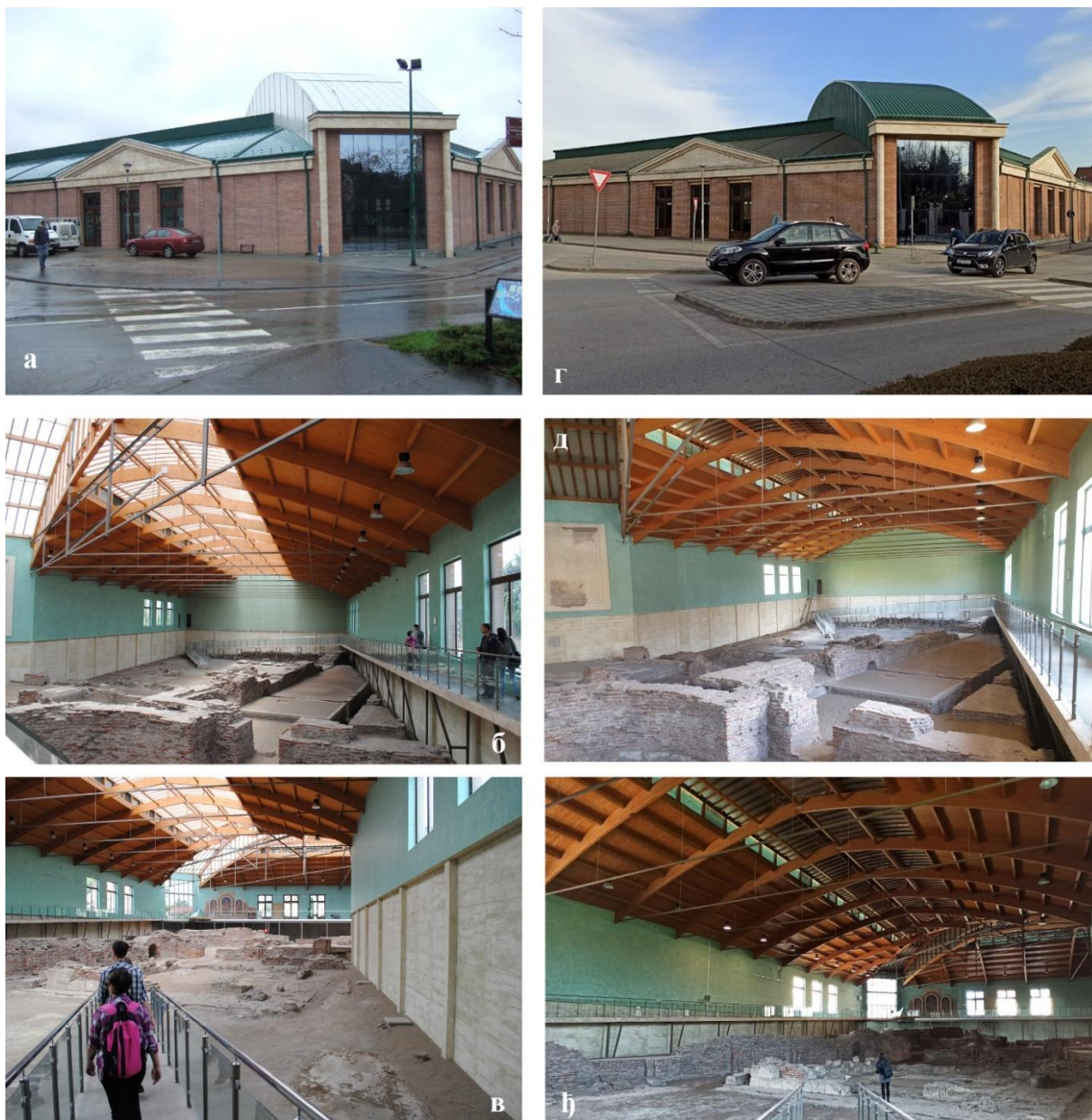
Слика 46. Постављање лименог покривача на лантерне у подужним деловима објекта и на свод, на углу: а, б, в) Визиторски центар пре покривања лантерни и свода на углу лимом и г, д, љ) Визиторски центар након покривања лантерни и свода на углу лимом. (Извор: Аутор).
