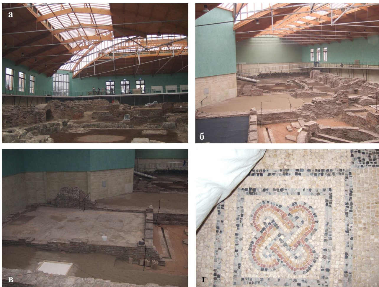
Слика 44. Промена микроклиматских услова средине након наткривања локалитета: а, б) унутрашњост локалитета непосредно након завршетка радова на изградњи Визиторског центра; в) Процес исушивања код мозаика у просторији 16 (M16) и г) код мозаика у просторији 14 (M14), (фотографисао: Иван Филиповић, архитекта – конзерватор).
