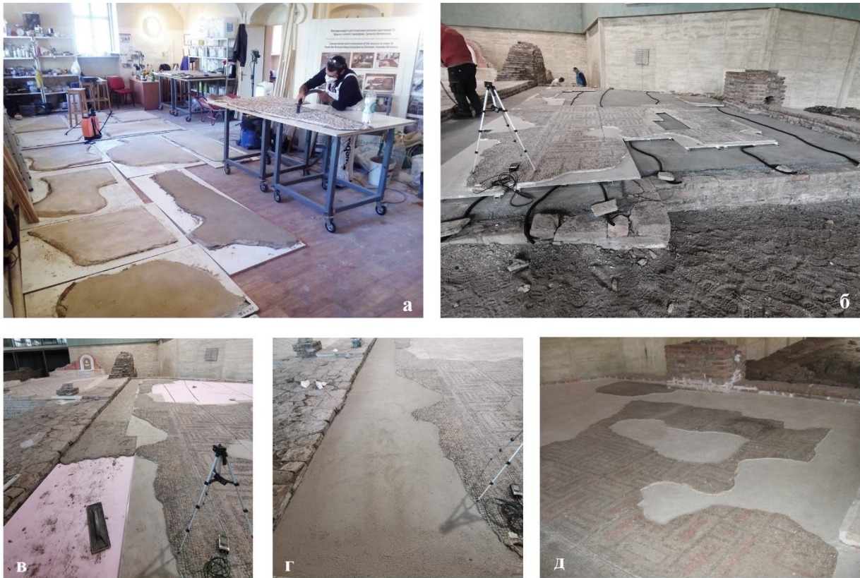
Слика 36. Реконзервација мозаика у просторији 23 (M23): а) реконзервација фрагмента мозаика на новој, алвеоларној подлози – носиоцу у радионици Завода за заштиту споменика културе у Сремској Митровици; б) поствљени алвеоларни панели на потконструкцију in situ у просторији 23; в) и г) изливање цементне кошуљице у зонама делова мозаика који недостају; д) мозаик након конзервације. (Извор: Завод за заштиту споменика културе у Сремској Митровици, фотографисала Јадранка Вулетић).
