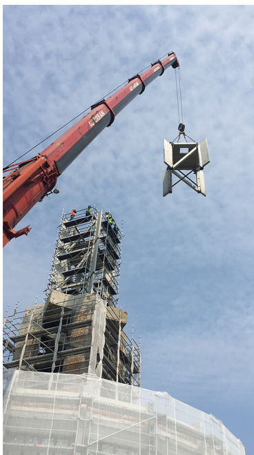
Сл. 43 Реконструкција Централне куле на Београдском сајмишту, 2023. године
