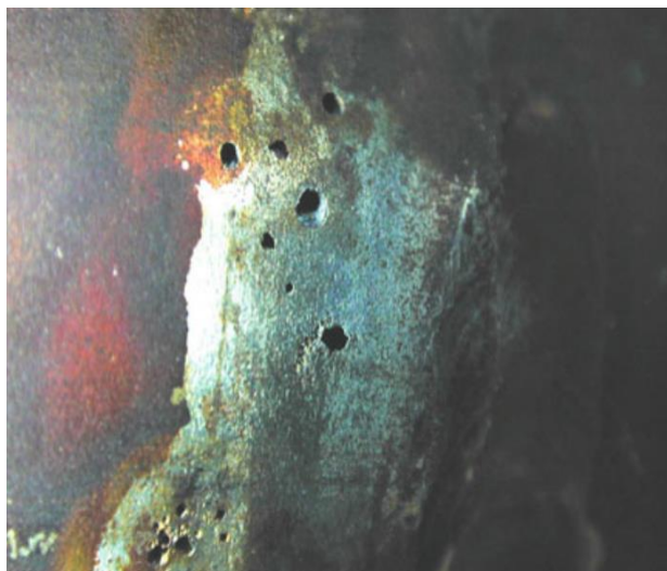
Slika 11. Piting korozija AISI 304 čelika u prisustvu hlorida [5]
