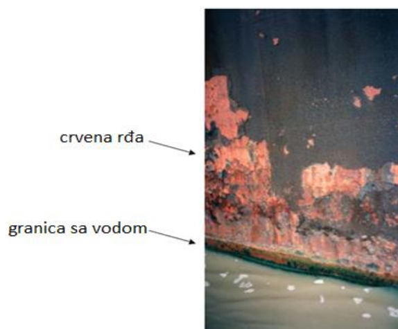
Slika 1. Dio broda koji je korodirao u kontaktu sa morskom vodom [10]
