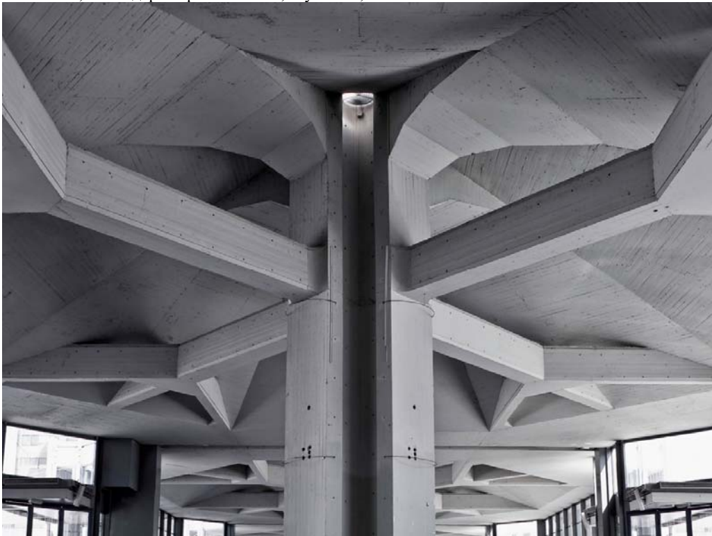
Сл. 63 Милан Михелич, Хала Ц, армиранобетонска печуркаста структура са комбинованим преносом оптерећења линијским и површинским елементима –Господарско разставишче, Љубљана, 1967.
