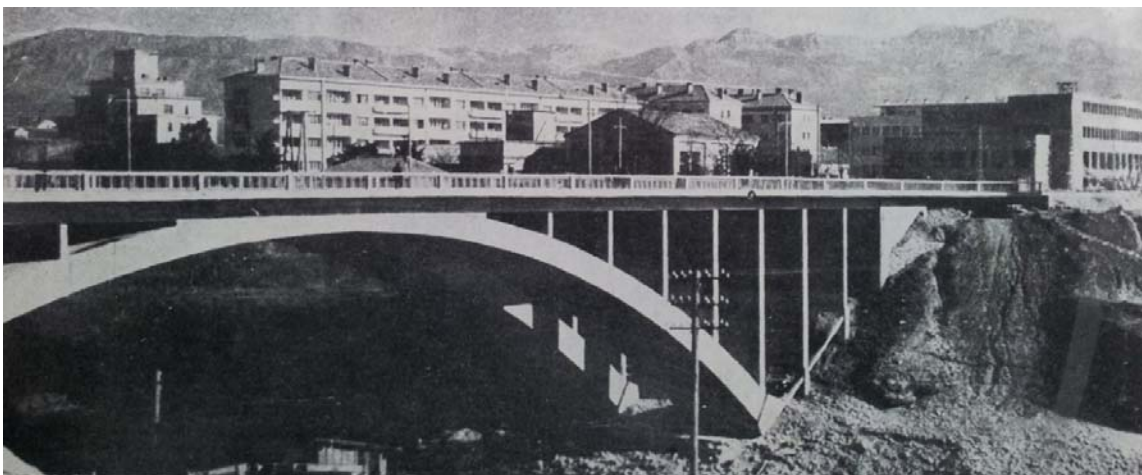
Сл. 230 Бранко Жежељ, Новица Вушовић, Крсто Филиповић, армирано-бетонски мост преко реке Мораче у Титограду. 1948-1950.
