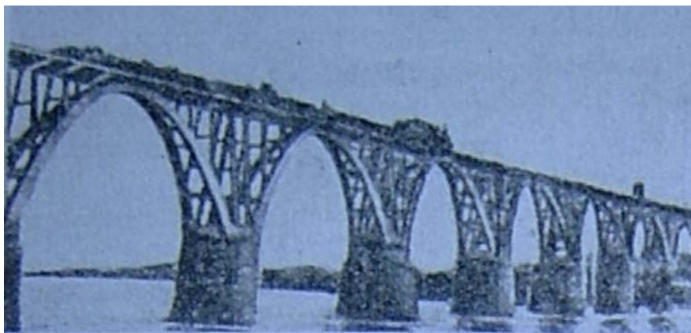
Сл. 223 Н. М. Колоков, мост преко реке Дњепар, 1931.
