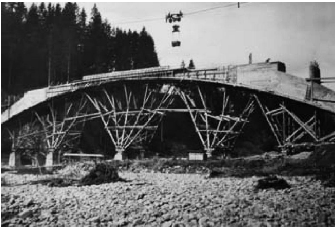
Сл. 217 Робер Мајар, изградња лучног моста Руегисберг (Rüeggisberg) у округу Берн, Швајцарска, 1932.
