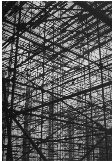
Сл. 379 Скела хале 3 Београдског сајма у изградњи, Београд 1954–1957.
