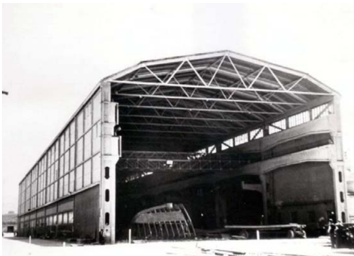
Сл. 287 (лево) Бранко Жежељ, преднапрегнута решеткаста конструкција распона 32 метра, хала бродоградилшта, Сплит, 1953.
