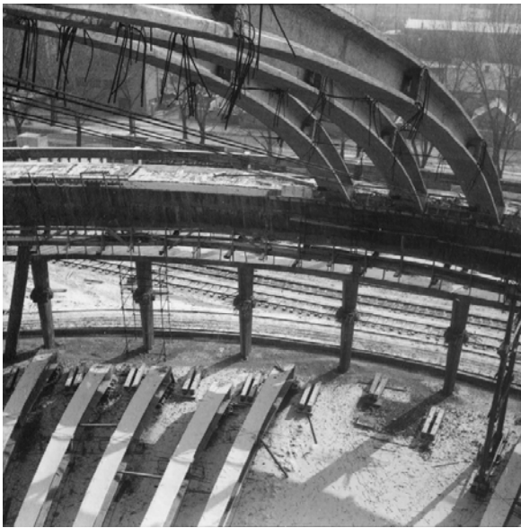
Сл. 357 (лево) Преднапрегнути прстен и делимично монтирани полулукови у положају потпорне линије лука, хала 1 Београдског сајма, Београд, 1955–1957.
