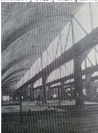
Сл. 255 (лево) Мирослав Грегорић, Данијел Смрекар, конструкција типског елемента шед-љуске фабрике Томос , Копар (Словенија), 1956–1961.
