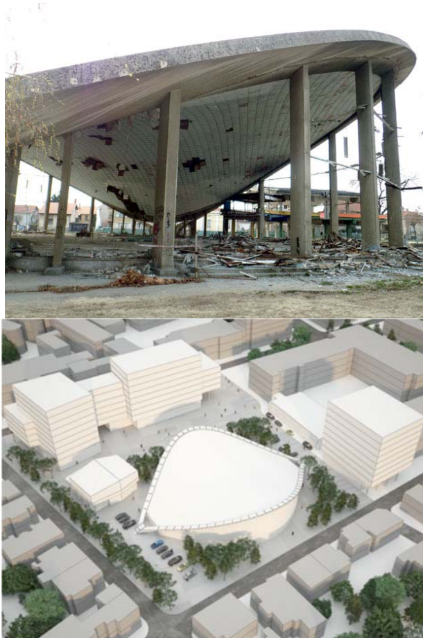
Сл. 89 (горе) Округли павиљон у фази реконструкције – сачувана је само основна армиранобетонска конструкција са седластим кровом и каснијом адаптацијом објекат је изгубио свој аутентични изглед и функцију
