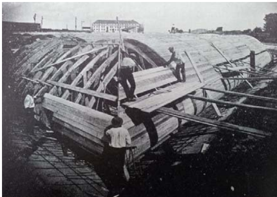
Сл. 209 и 210 Јуре Дензлер, резервоар на Лашћинском путу (оплата армиранобетонске конструкције), Загреб, 1932.
