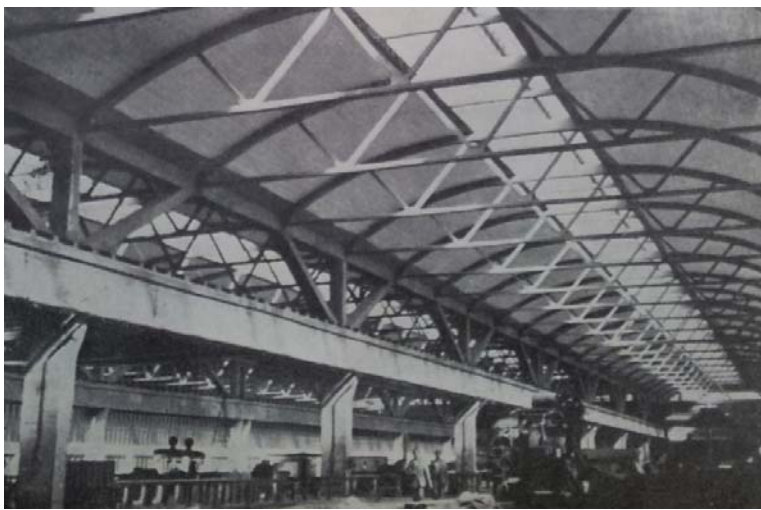
Сл. 250 Ото Вернер, приказ унутрашњости и кровне конструкције хале, Ваљаоница, Сисак, 1955.
