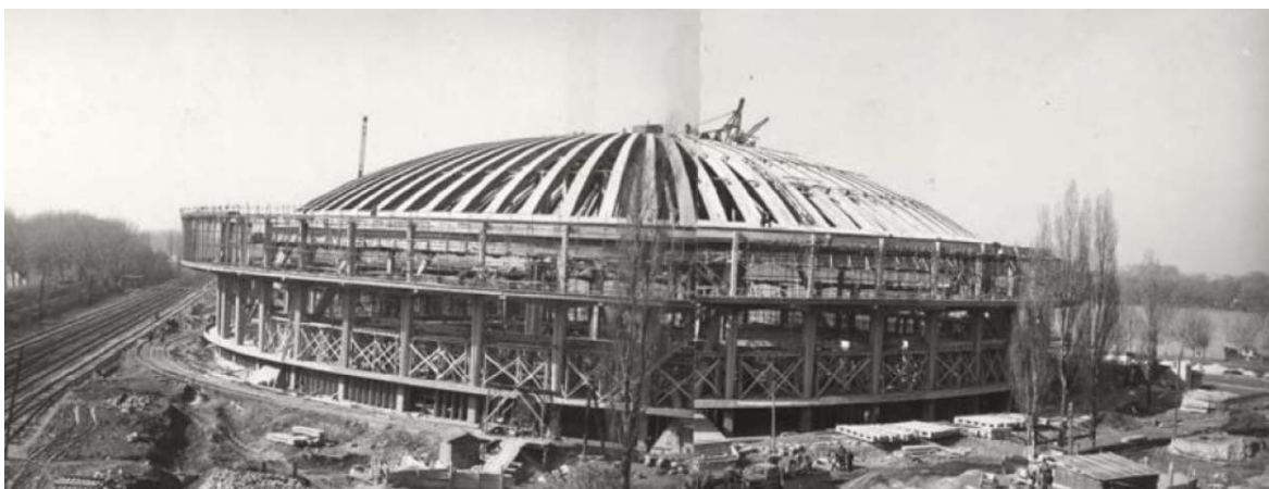
Сл. 336 Изградња хале 1 Београдског сајма – видљива аналогија са Палатом спортова у Риму. Београд 1955-1957.
