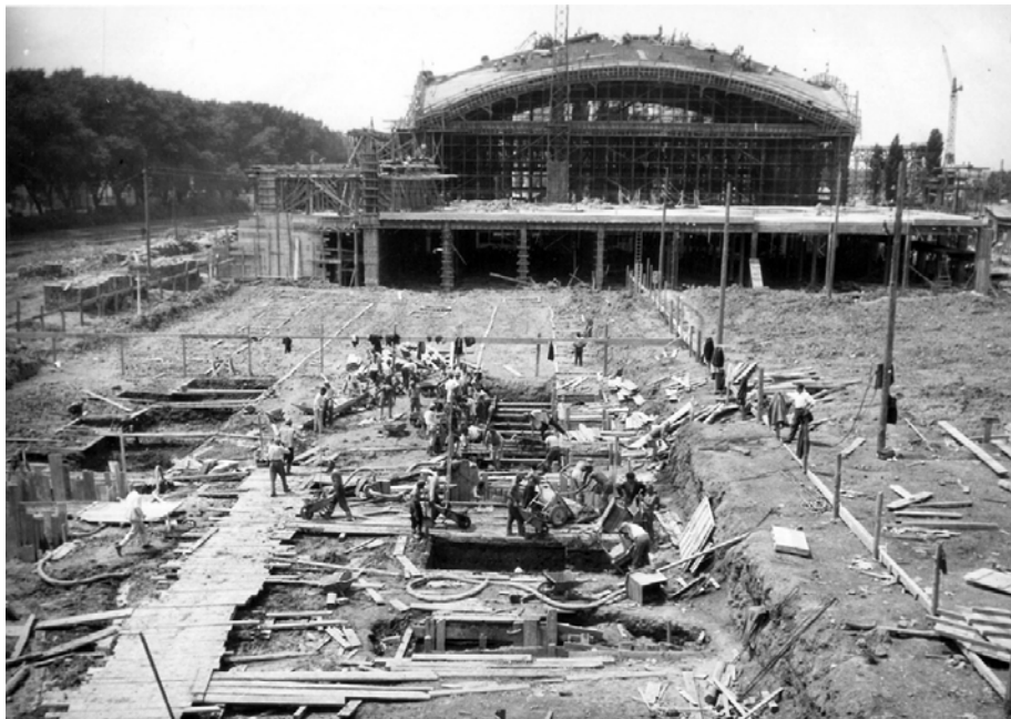
Сл. 366 Радови на фундаирању пролазне хале (која спаја халу 2 и 3) и хала 2 Београдског сајма у изградњи, Београд 1955–1957.
