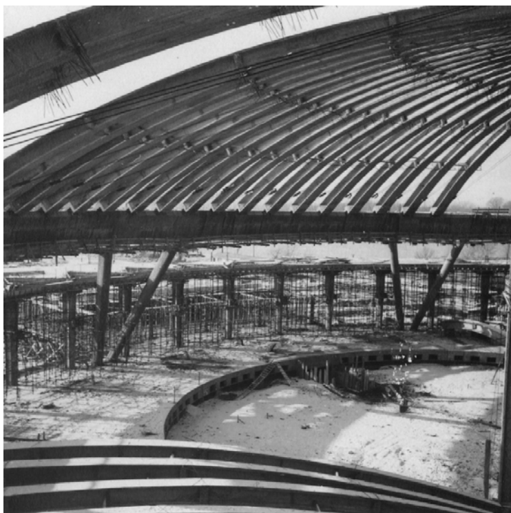
Сл. 344 Изградња хале 1 Београдског сајма – делимично урађена примарна конструкција куполе од 80 полулукова укљештених у преднапрегнути прстен ослоњен на косим стубовима, Београд, 1955–1957.
