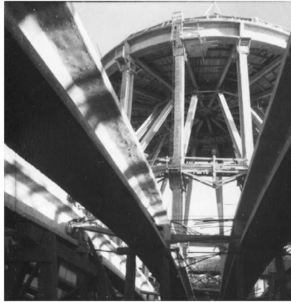
Сл. 357 (лево) Преднапрегнути прстен и делимично монтирани полулукови у положају потпорне линије лука, хала 1 Београдског сајма, Београд, 1955–1957.
