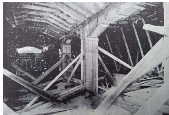
Сл. 209 и 210 Јуре Дензлер, резервоар на Лашћинском путу (оплата армиранобетонске конструкције), Загреб, 1932.
