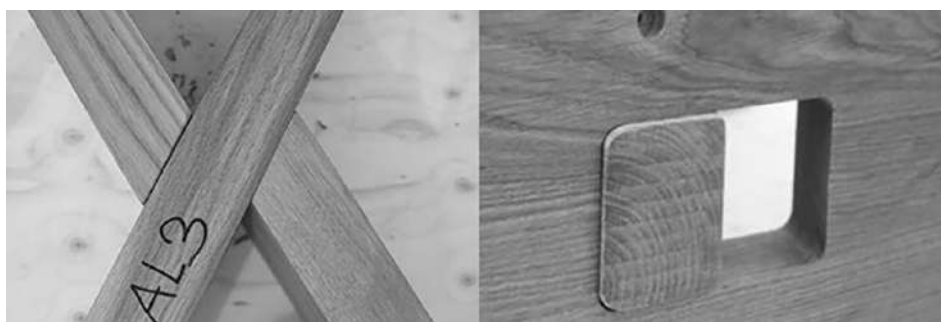
Слика 7.2-5. Тесарска веза примењена за двоводни кров. Лева слика приказује остварену везу ламела, а на десној се налази детаљ средишње ламеле са постављеном једном прикључном ламелом, извор: Bath Bespoke.
