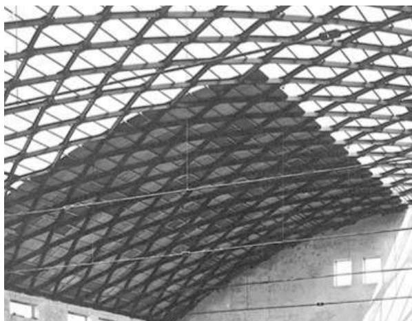
Слика 2-8. Дено за рафинерију шећера, конструкција Хунебек (сегмент фотографије), извор: Wolf, 2020, 126.
