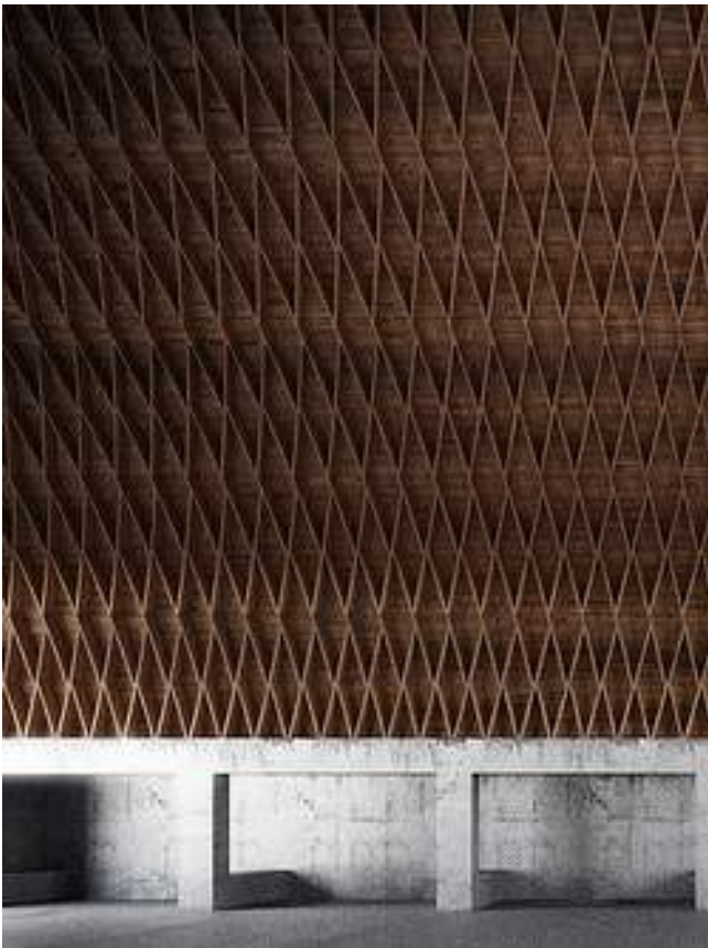
Слика 2-5. Унутрашњост амбара, Gut Garkau 1923-1926, архитекта: Хуго Харинг (Hugo Häring), конструкција: Фридрих Золингер, извор: designcouncil.tumblr
