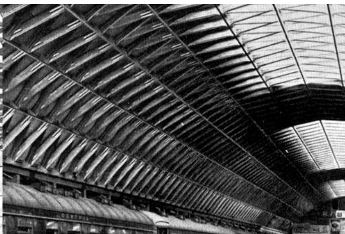
Слика 2-9. Конструкција железничке станице, Хуго Јункерс (сегмент фотографије), извор: Detail 10/2015
