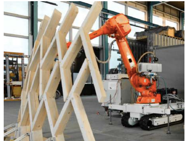
Слика 2-16. Сегмент лам. конструкције монтиране роботском руком, извор: Apolinarska, 2018.
